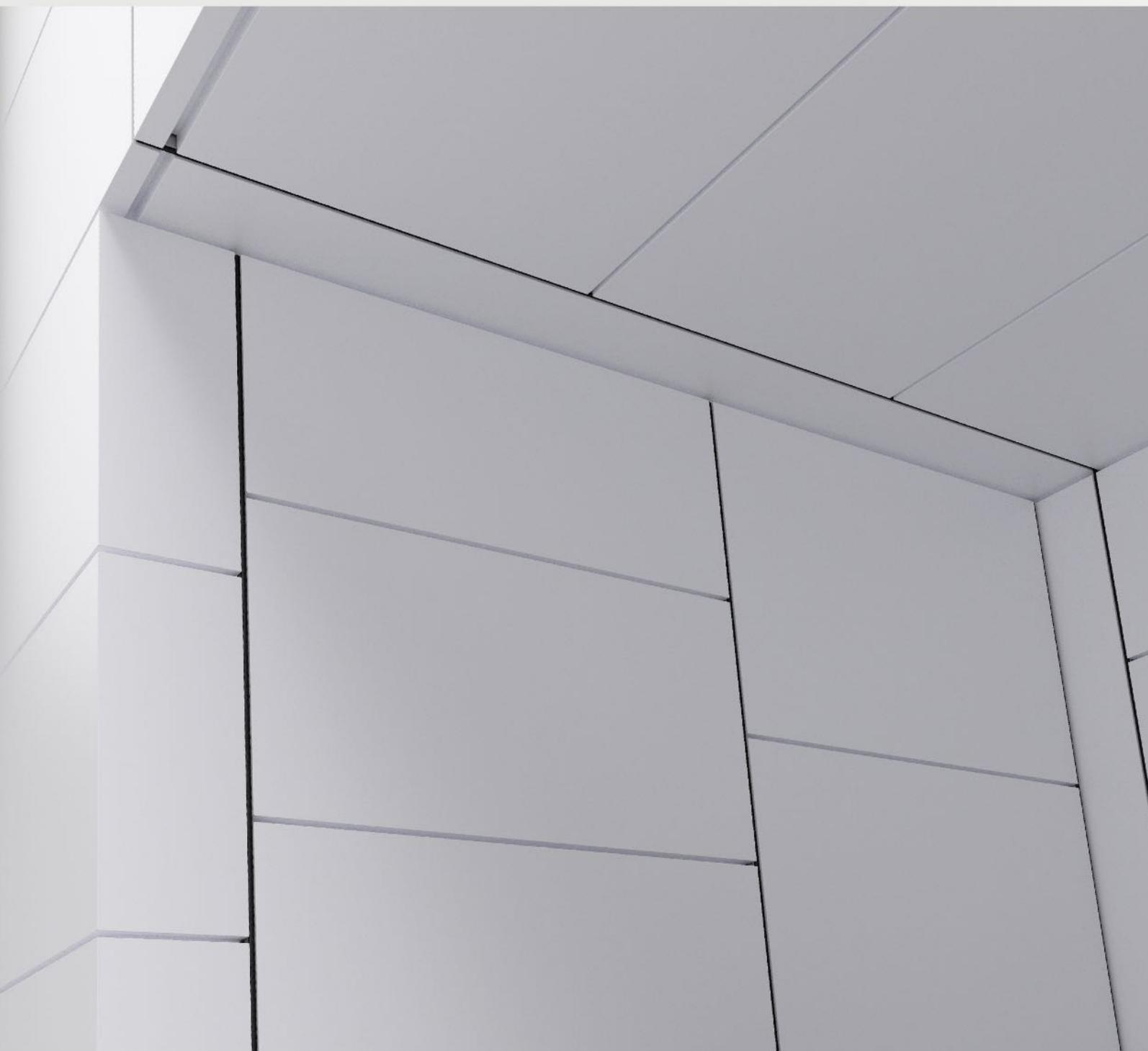
**Fig.09.f** | In questa vista si può notare in dettaglio lo sfalsamento orizzontale dei pannelli.
