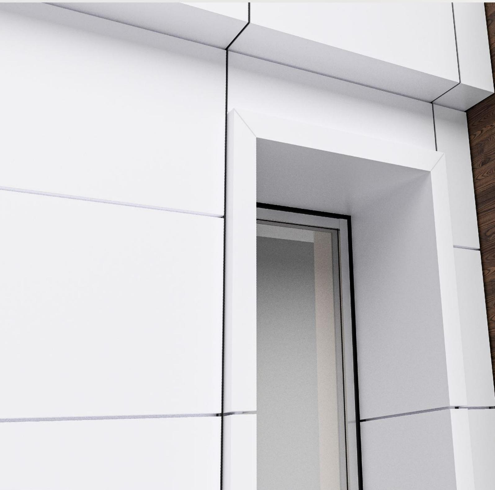
**Fig.09.d** | In questa vista si può notare in dettaglio un serramento in vetro e il relativo imbottito con modanatura di rivestimento tagliata a 45°.
